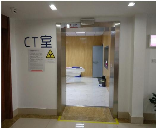
图 6-7 防护门电离辐射标志和辐射安全警戒线
