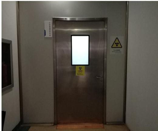
图 6-8 防护门电离辐射标志和辐射安全警戒线
